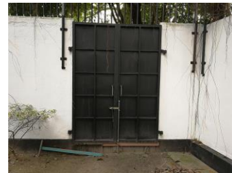
公園側の避難扉
